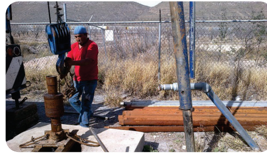
Trabajos en pozos de agua
