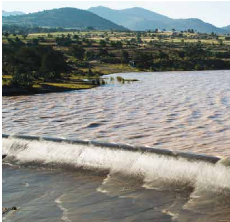
Presa Lázaro Cárdenas, Tlaxcala.
