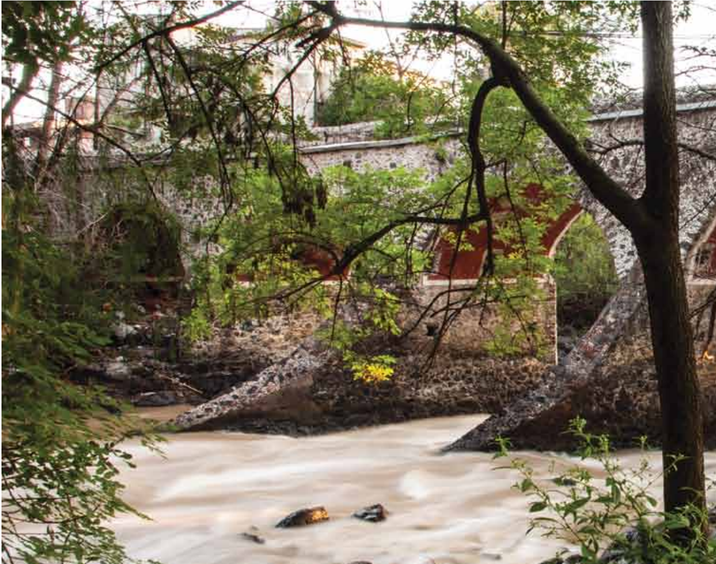
Puente Batanes, Guanajuato.
