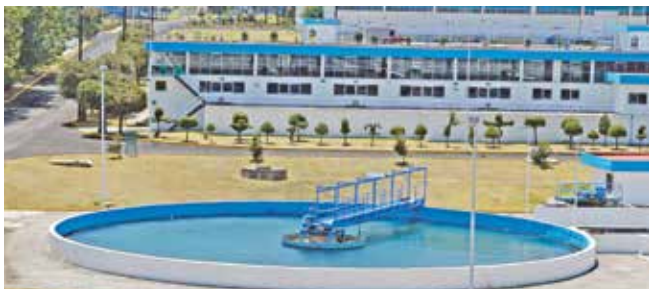
Planta de tratamiento de aguas residuales. Fuente: SEMARNAT, 2012
