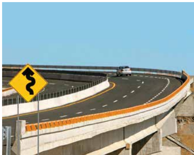
Autopista Amecameca-Cuatla. Fuente: Presidencia de la República, 2014
