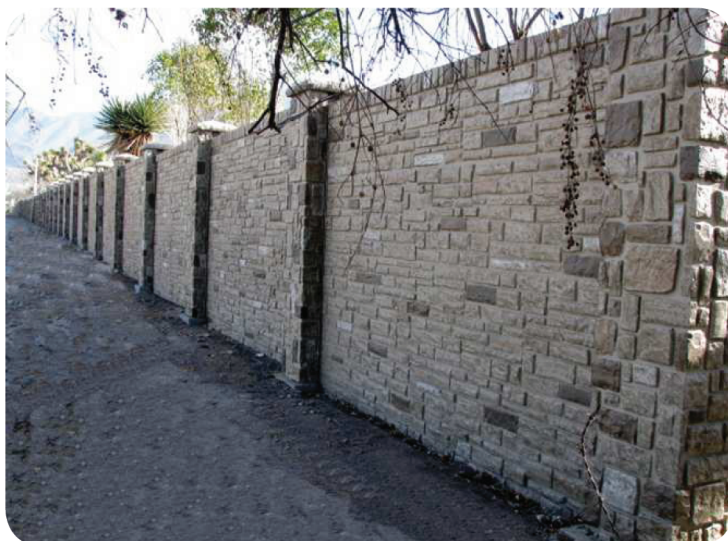
Barda perimetral en el campus sede
