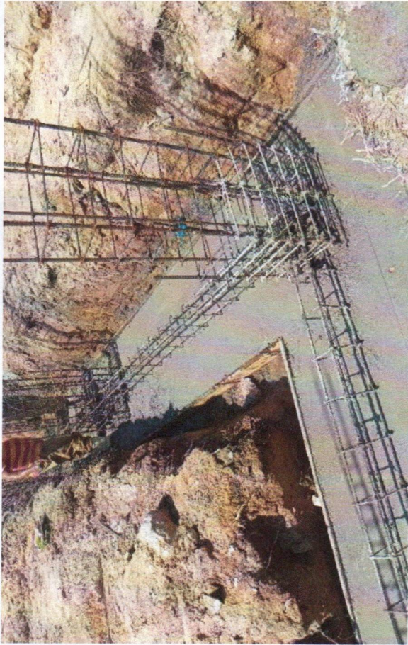
Concreto f'c=250 \text{ kg/cm}^2 fabricado en obra
