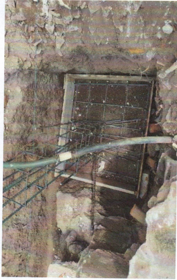
Anclaje de castillo en cimentación de 14x15cms
