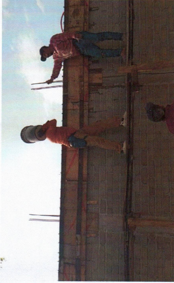
Cadena o castillo de concreto, f_c = 250 \text{ kg/cm}^2 , de 14 \times 30 \text{ cms}
