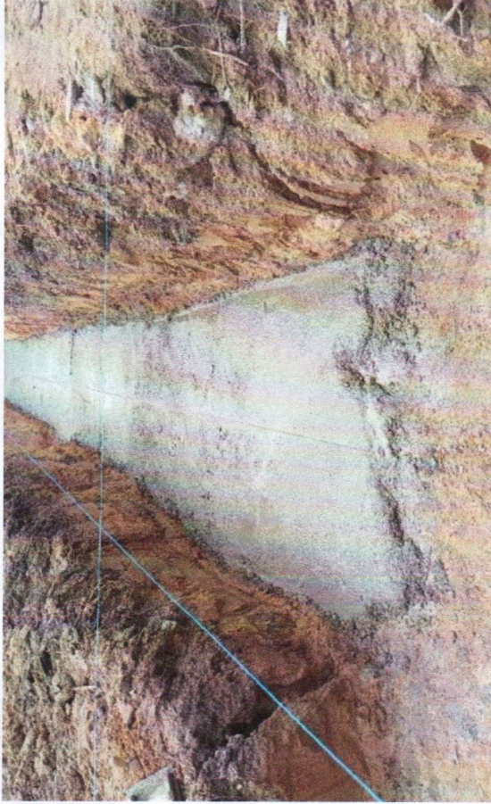
Albañilería.- Plantilla de concreto de 5 cm
