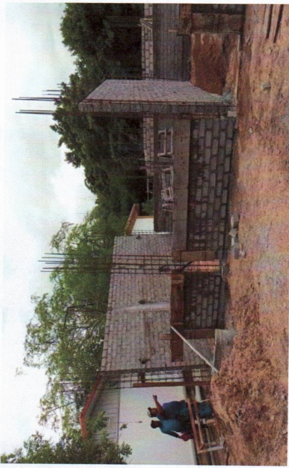
Cadena de concreto f_c=250 kg/cm 2 de 14x10 cm.
