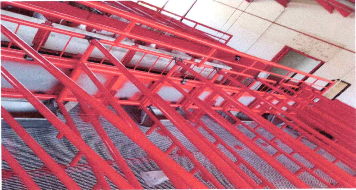
INSTALACION DE PUERTAS DE APRETAMIENTO DE VIENTRES PORCINOS
