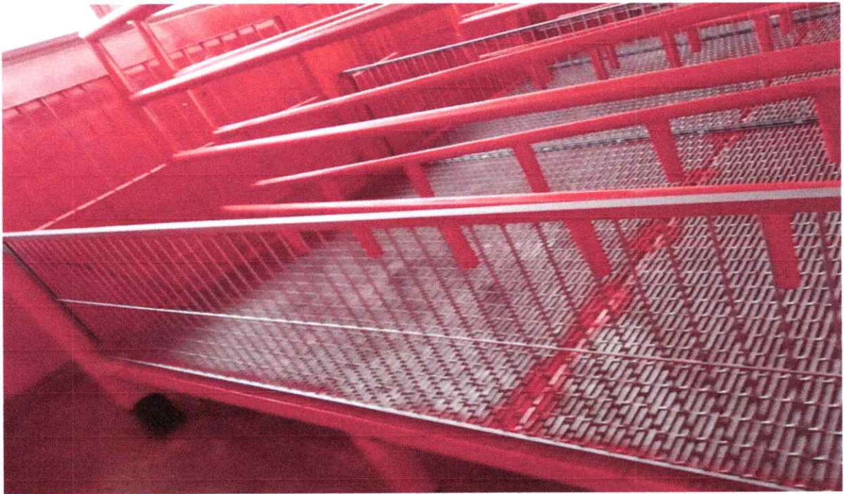
LA INSTALACION DE SEPARADORES DE JAUJAS FABRICADOS CON PANEL GALVANIZADO EXCLUSIVO PARA LECHONES EN DESTETE, CON ANGULO DE REFUERZO DE \frac{3}{4} " CAL 1/8" PINTADOS CON PINTURA DE FONDO Y EXTERIOR COLOR ALUINIO
