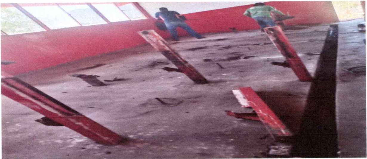
TERMINO DE DESMANTELAMIENTO DE JAULAS, RETIRO DE MATERIAL Y LIMPIEZA DE AREA DE TRABAJO
