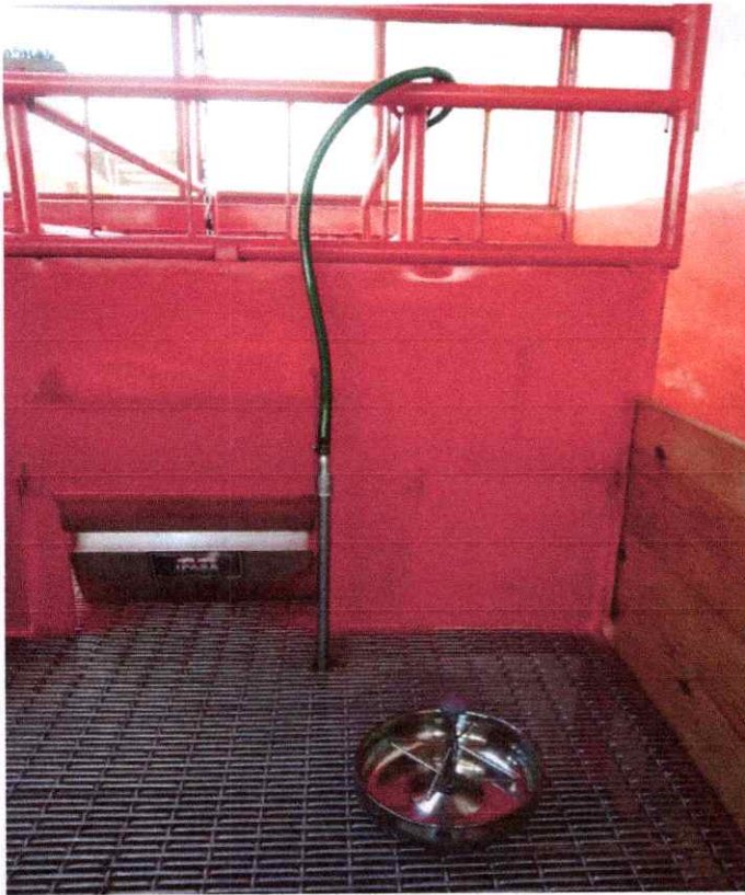
INSTALACION DE SISTEMA DE AGUA CON TUBO DE ½" GALVANIZADO, LLAVES DE PASO DE ½, CHUPON BEBEDERO DE ACERO GALVANIZADO, MANGUERA TIPO JARDINERA DE ½" TRICAPA, COMEDERO DE ACERO GALVANIZADO PARA LECHONES Y VIENTRES
