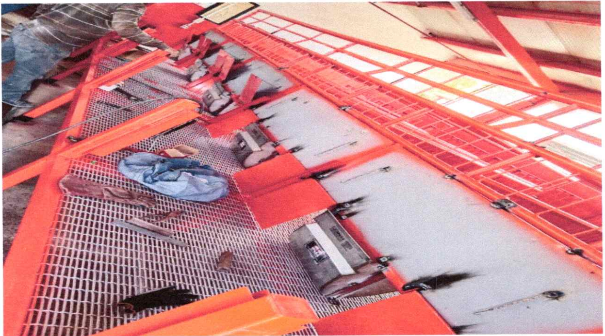
INSTALACION DE PUERTAS DE MANEJO DE LECHONES PARA AREA DE ENCUBACION E INSTALACION DE COMEDEROS FABRICADOS EN ACERO INOXIDABLE CAL 16
