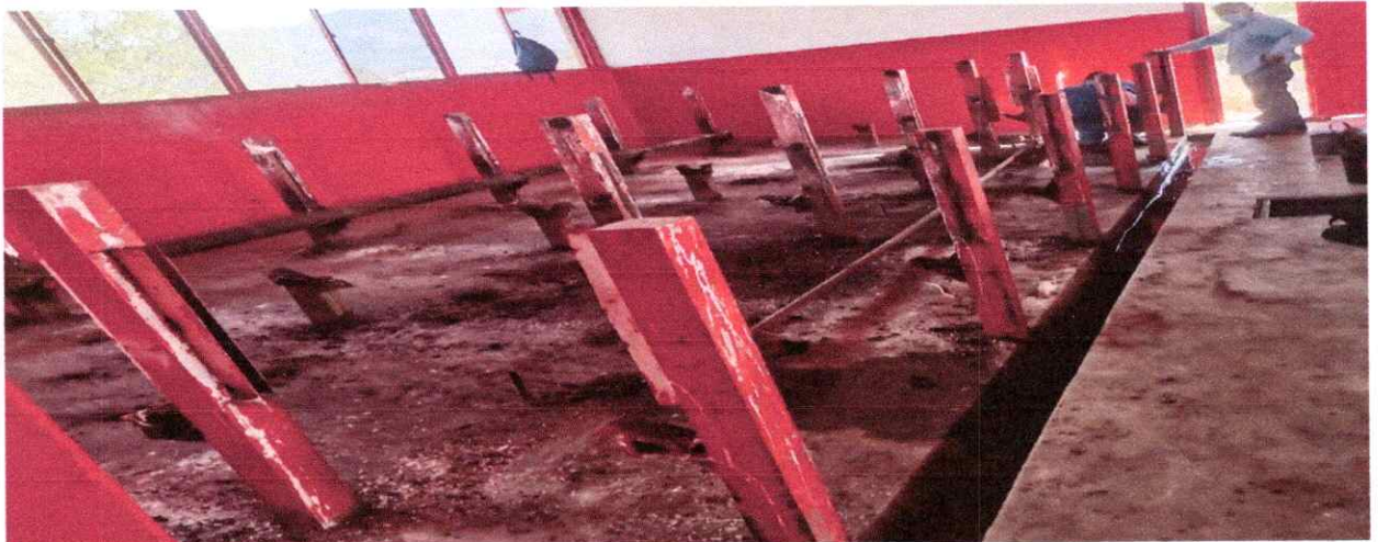
RETIRO DE MALLA DE PISO PORCICOLA Y DESMANTELAMIENTO DE POSTES DE SUJECION DE LAS JAULAS
