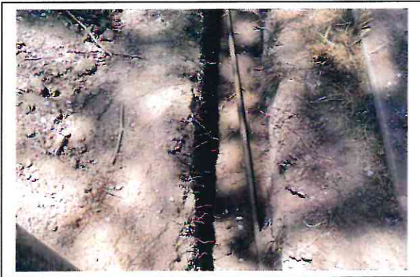
EXCAVACION PARA CIMENTACION.
