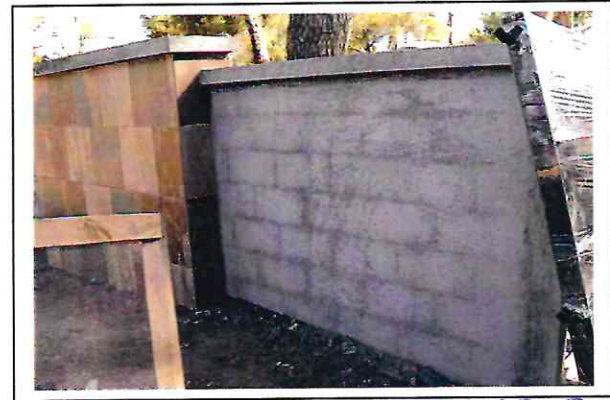
PASTA EN MURO Y VITROPILO
