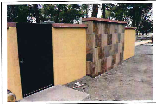
PUERTA METALICA DE ACCESO.
