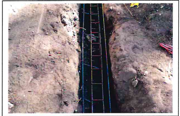
ARMADO DE ZAPATA DE CIMENTACION.
