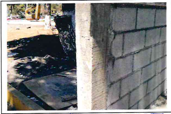
CASTILLO DE CONCRETO ARMADO
