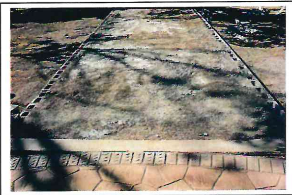
PISO DE CONCRETO ESTO MPAD
