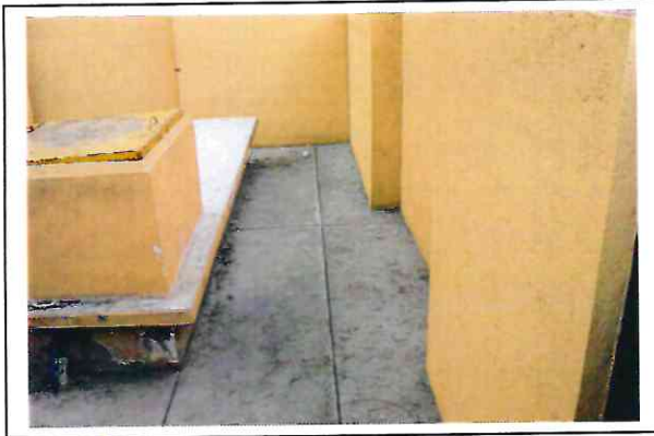
PISO DE CONCRETO INTERIOR.
