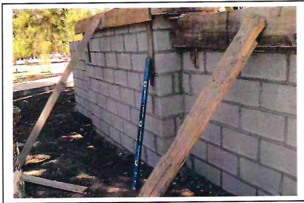
VACIADO MOLFORMA DE CONCRETO
