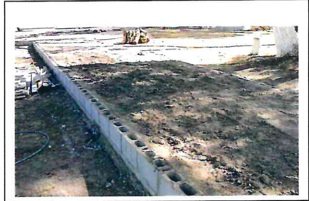
ENTRASE DE BLOCK DE CONCRETO
