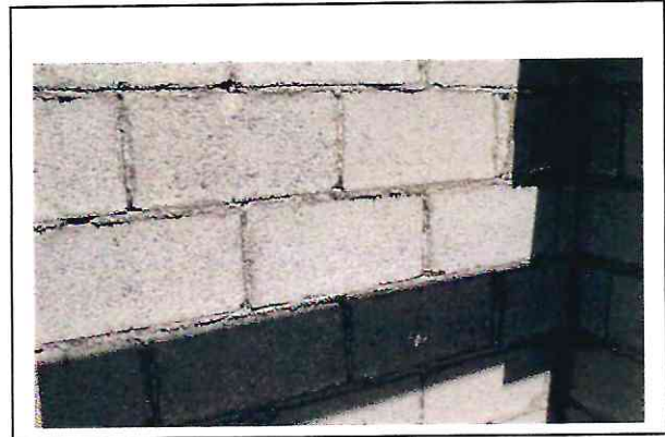
MURO DE BLOQUE DE CONCRETO
