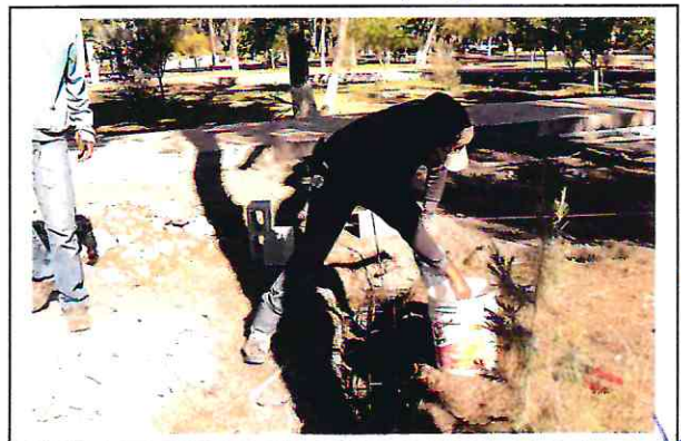
VACIADO DE CONCRETO CIMENTACION.
