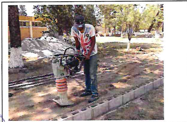
RELLENO Y COMPACTACION DE TERRENO
