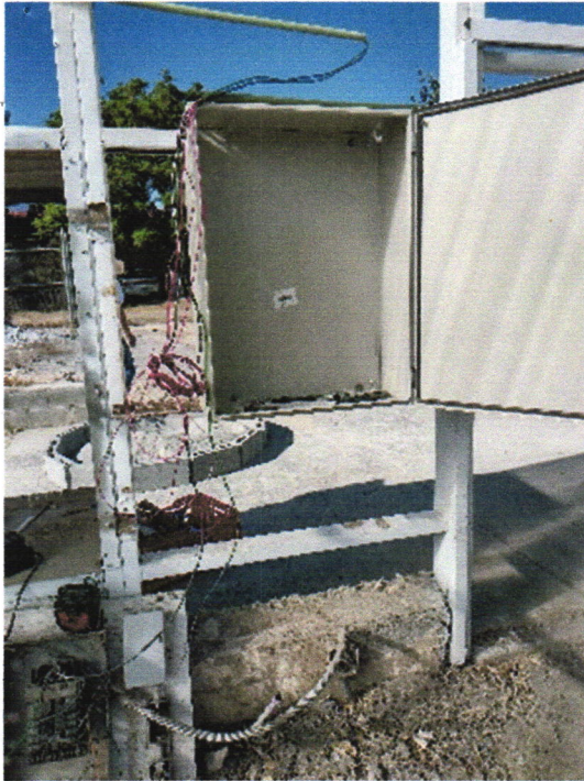
Montaje de Gabinete
