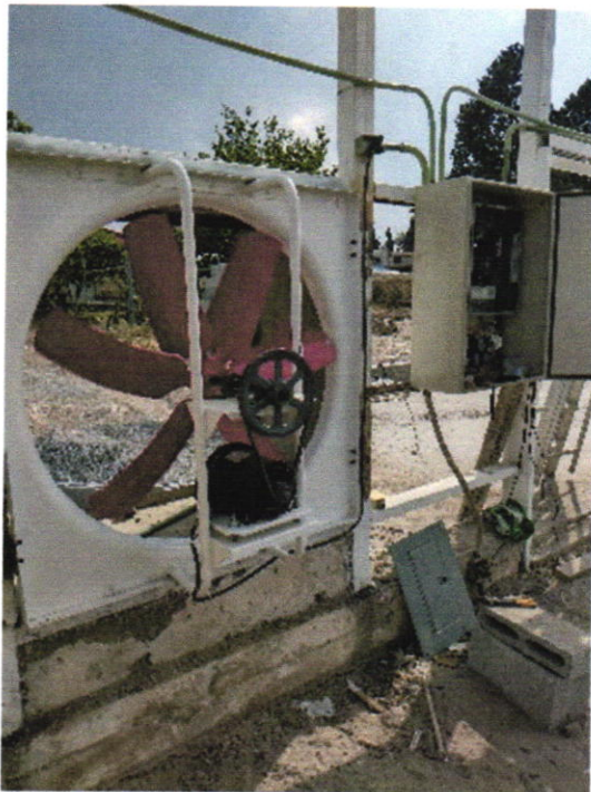
Montaje de extractor y conexión eléctrica del motor trifásico
