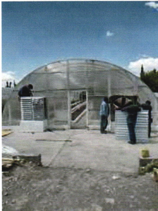
Montaje de persianas en ambos extractores
