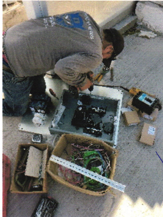
Preparado de tablero de centro de automatización
