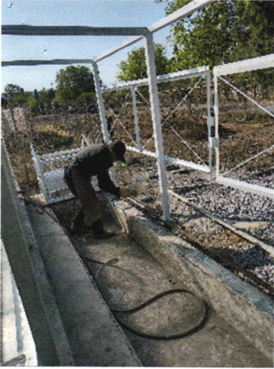
Proceso de aplicado de pintura esmalte con equipo de presurización
