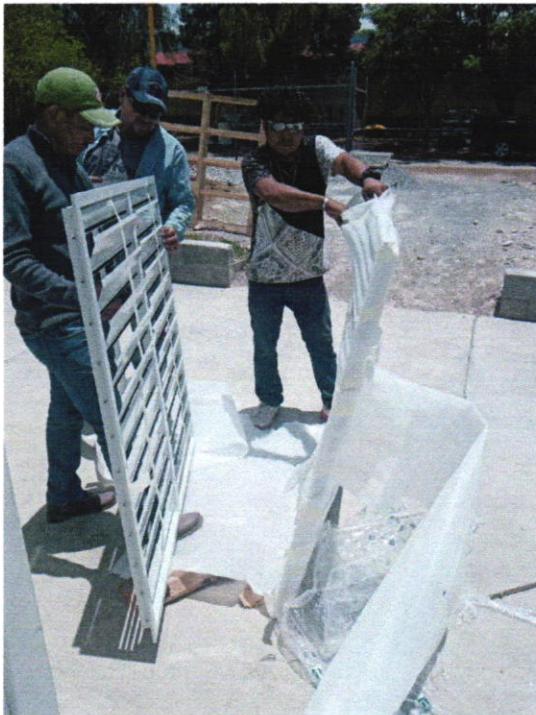
Montaje de persianas de sobrepresión construidas de aluminio
