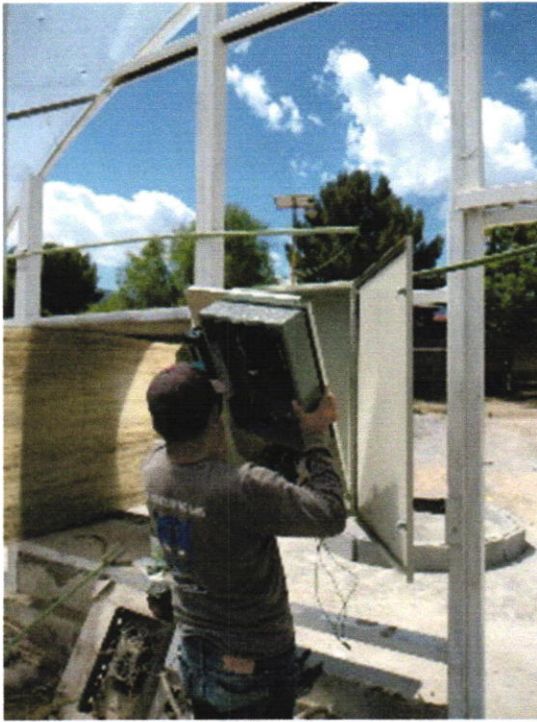
Montaje de tablero
