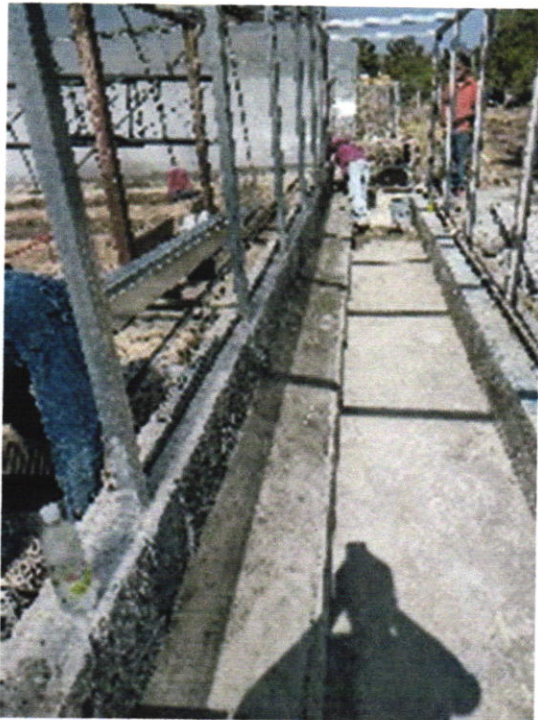
Avance en la rehabilitación de la estructura del área de aislamiento de la pileta de la pared húmeda
