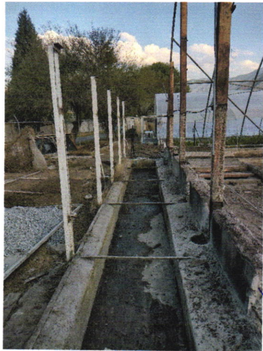
Eliminación de bastidores y limpieza de postes
