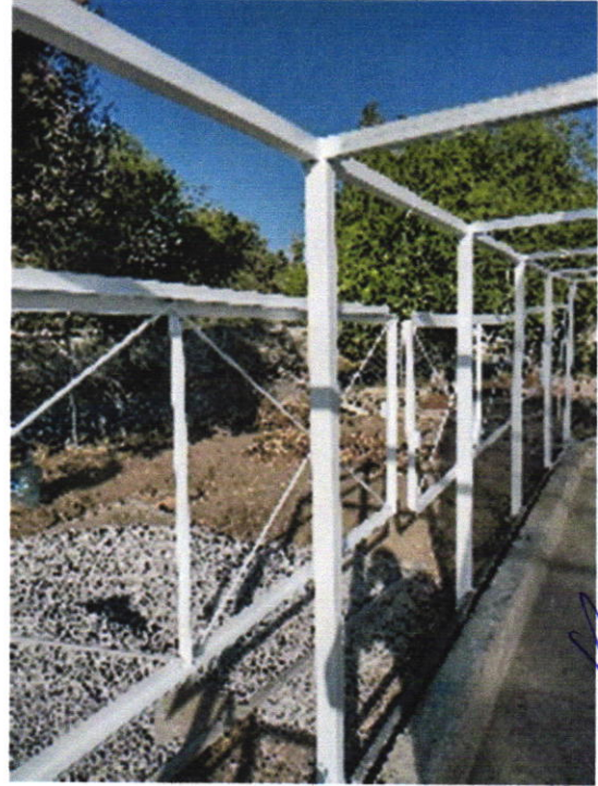
Estructura terminada del proceso de pintura
