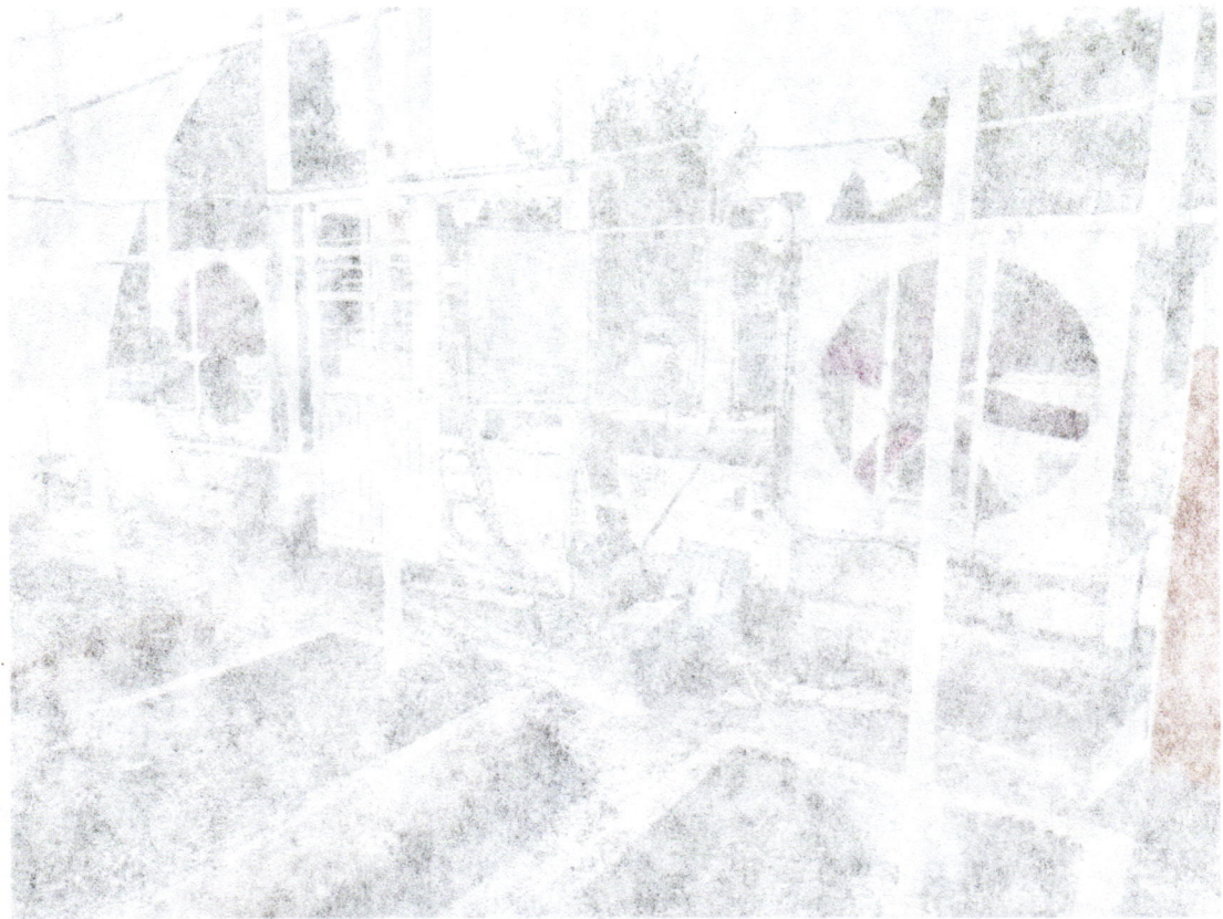
Prueba de extractores, funcionamiento de los motores trifásicos operados por sensor de temperatura
