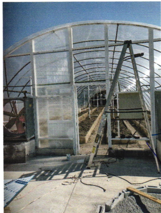
Una vez terminado el montaje de los extractores, se terminó de cubrir las partes frontales del invernadero, puesto que la acumulación de temperatura afectaría con anterioridad
