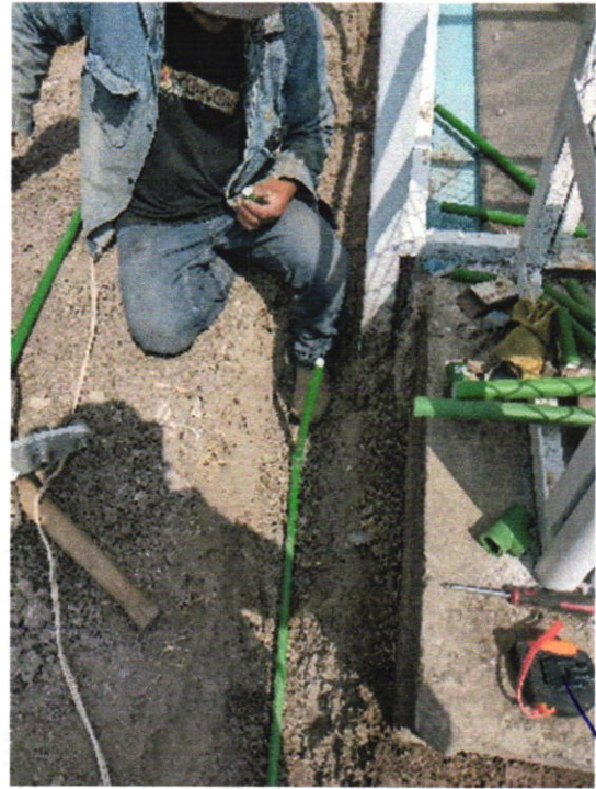
Preparación para la instalación de válvula flotador
