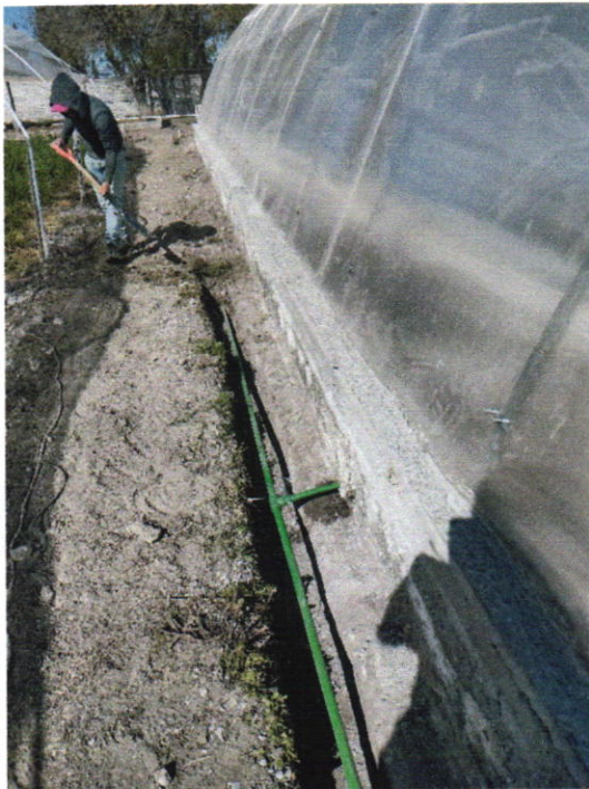
Conexiones de línea de abastecimiento de agua en invernadero, pileta, y tinacos y camas de lombriz
