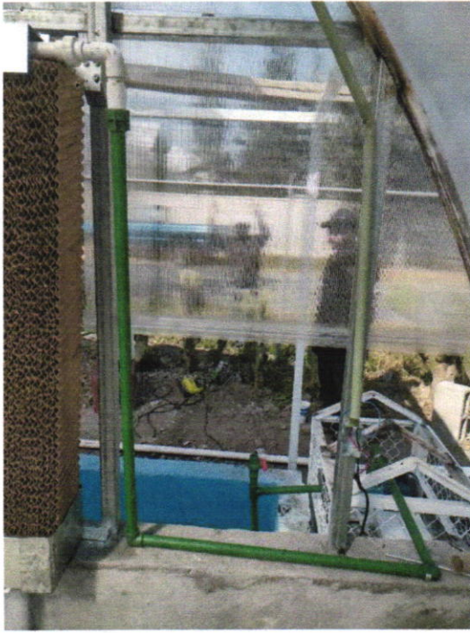
Montaje de línea de abastecimiento de agua en pared húmeda
