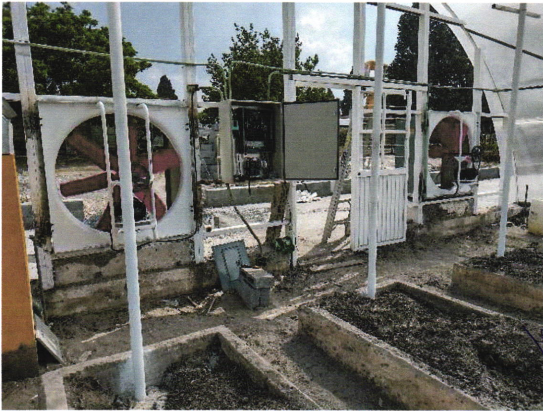
Prueba de extractores, funcionamiento de dos motores trifásicos operados por sensor de temperatura
