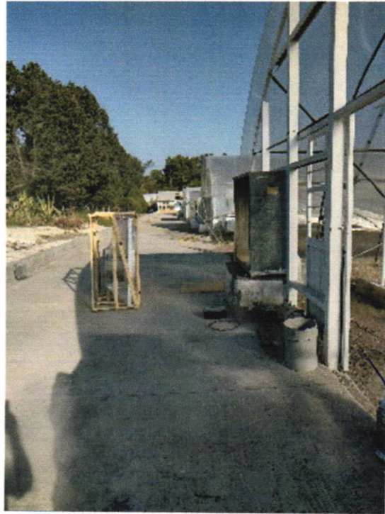
Desembalaje de extractores listos para su montaje
