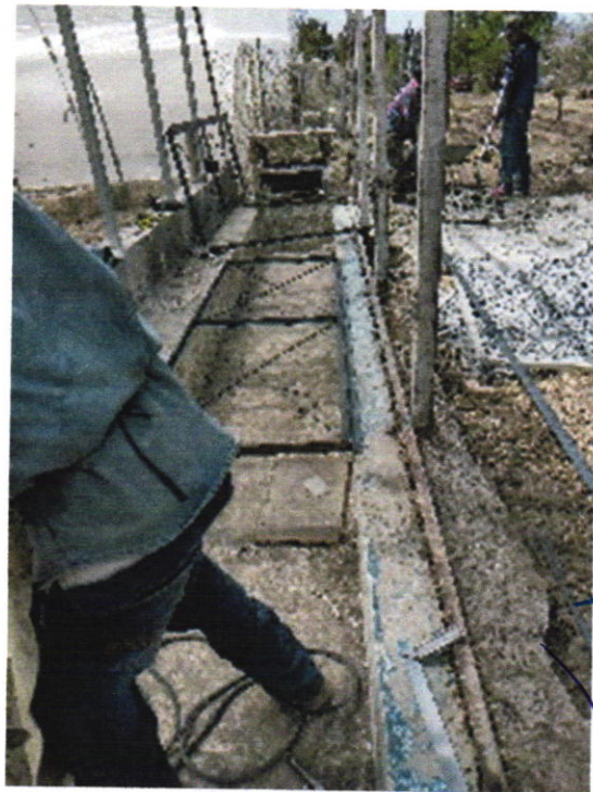
Fabricación de los bastidores de las tapas para la pileta
