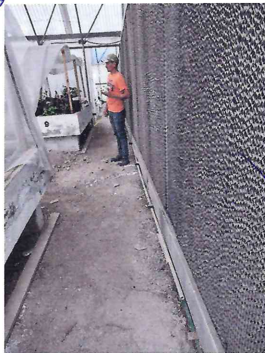
TENDIDO DE CUERDAS PARA LA NIVELACION DE TERRENO EN PASILLOS
