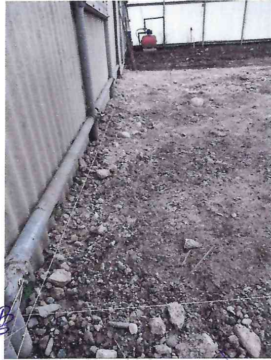
EL TENDIDO DEL RELLENO SE USO AGUA Y PIZON PARA LA NIVELACION Y DESNIVEL DE ESCURRIMETO
