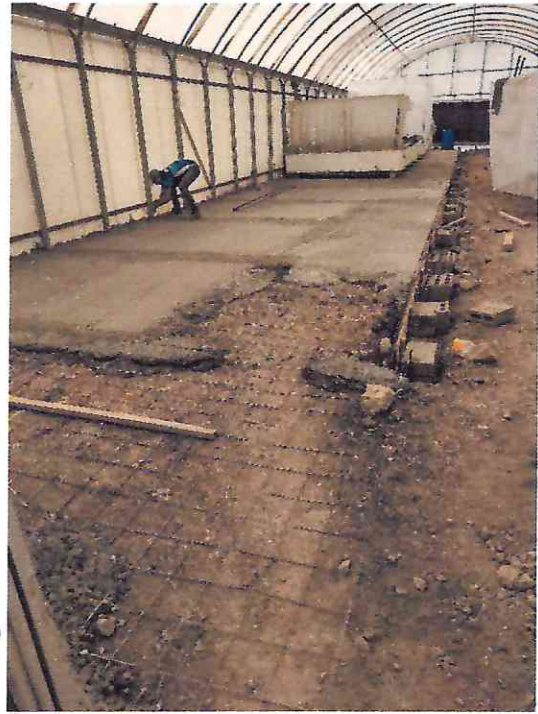
SIGUEN LOS AVANCES DE LA PRIMERA ETAPA DEL SUGUNDO TUNEL
