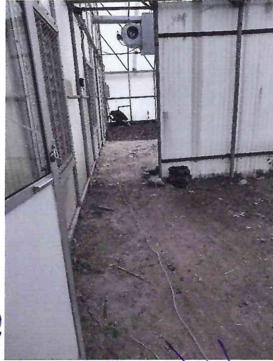
NIVELACION DE PISO DE TUNELES
