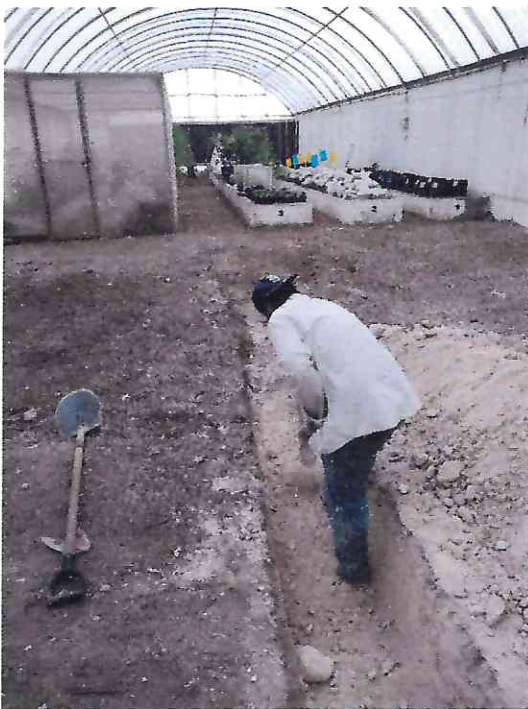
EXCAVACION DE ZANJA PARA DRENAJE
