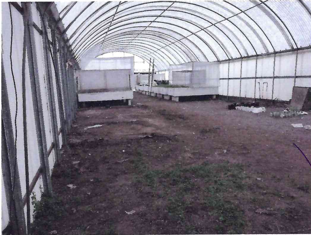
VISTA GENERAL DEL INTERIOR DE LOS TUNELES DEL INVERNADERO No. 9 DE PARASITOLOGIA
