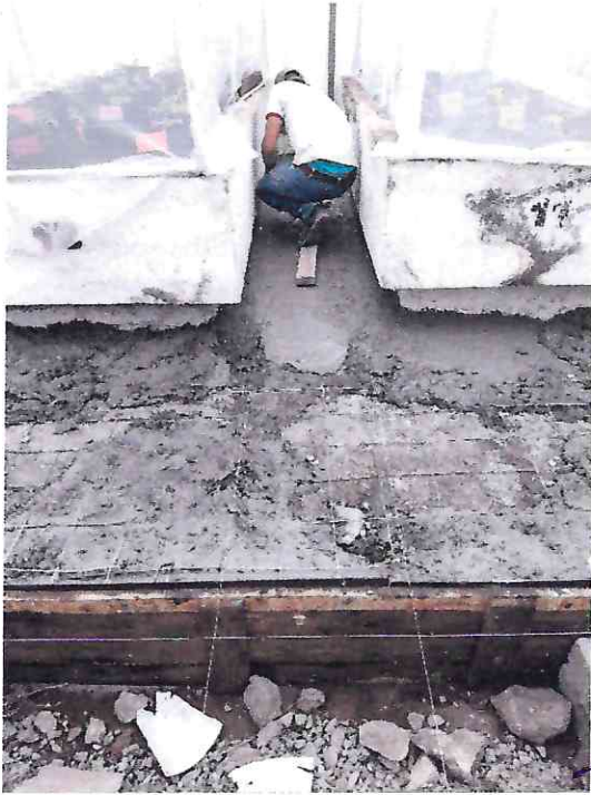
AVANCE DEL TENDIDO DE CONCRETO EN PASILLOS Y BAJO LAS CAMAS
