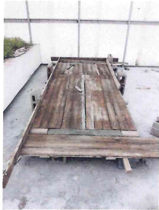
PREPARACION DE LA CONSTRUCCION DE DOS CAMAS DE TRABAJO PARA CULTIVOS DE INVESTIGACION
