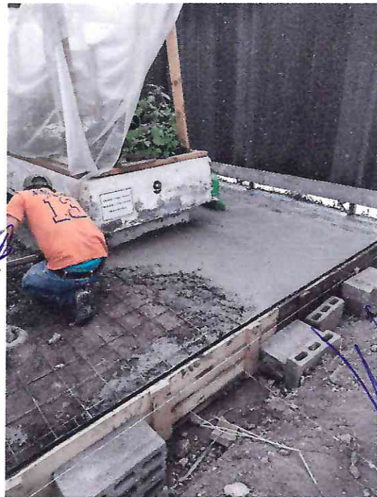
SE PROCEDE AL TENDIDO DE CONCRETO, EN ESTE PROCESO FUE DONDE SE EMPOZO A DIFICULTAR EL TRABAJO, POR LAS CAMAS YA EXISTENTES
