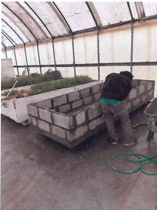
CONSTRUCCION DE MURETES DE CAMAS
