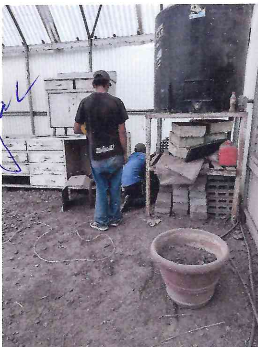
TRAZADO Y NIVELADO DE TERRENO, Y DESPEJE DE AREA DE TRABAJO
