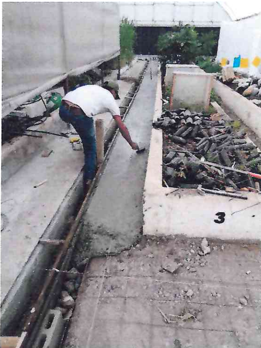
AVANCES DE TENDIDO DE CONCRETO DE LA SEGUNDA SECCION
