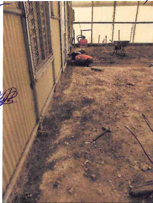
DETALLADO DE ZANJA DE DRENAJE
