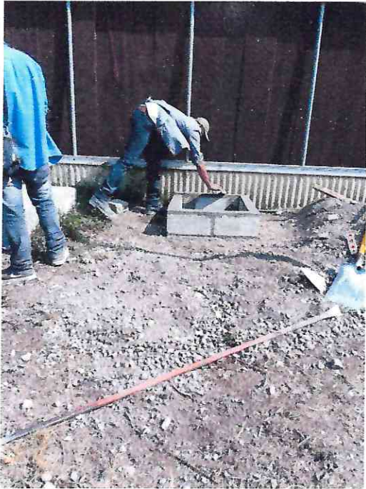
CONSTRUCCION DE REGISTRO DEL CANAL DE DESGUE
