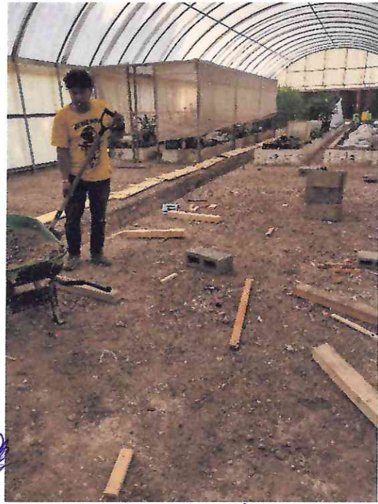
PREPRACION DE MADERA PARA EL ENCOFRADO
