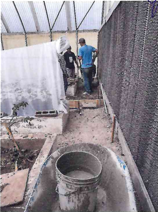
SE INICIA CON LOS TRABAJOS DE VACIADO DE CONCRETO EN LA PARTE POSTERIOR DEL INVERNADERO
