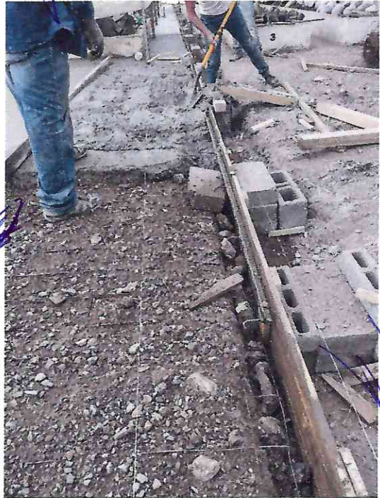
AVANCES DEL TENDO DE CONCRETO
