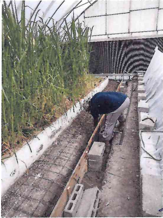
COLOCACION DE ANGULO PARA BASTIDOR DE REJILLA
