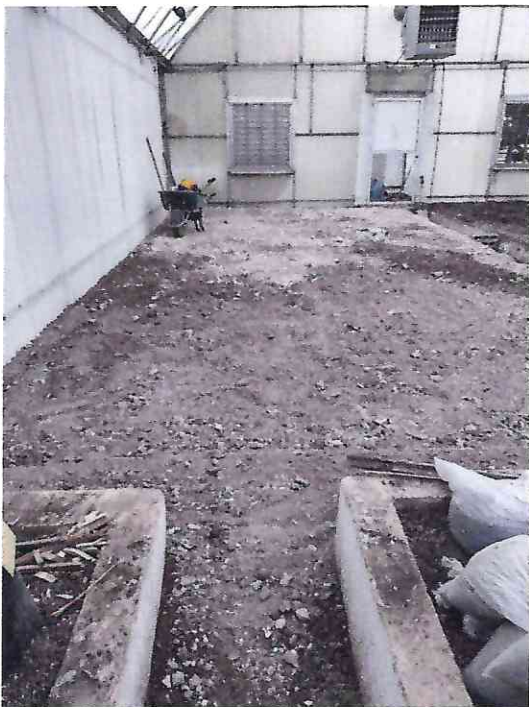
AREA PREPARADA PARA LA COLOCACION DE PISO DE CONCRETO
