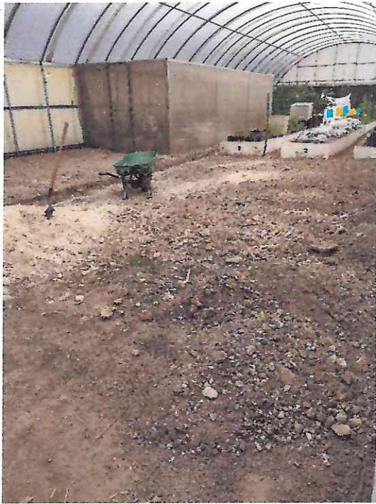
SE PROCEDIO A RELLENAR EL AREA CON TIERRA Y CASCAJO
