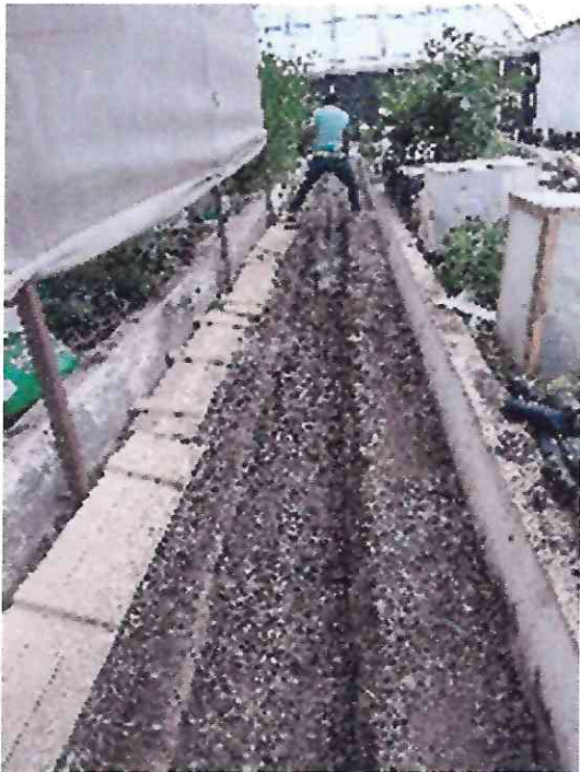
TENDIDO DE PISO EN CANAL DE DRENAJE
