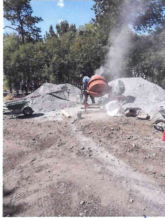
PARA LA PREPARACION DE LA MEZCLA DE MATERIALES, FUE NECESARIO EL USO DE UNA REVOLVEDORA
