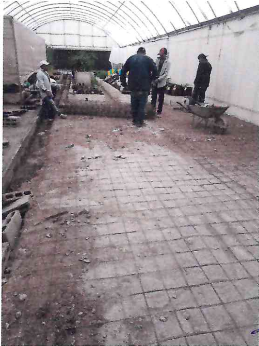
POSTERIOR AL TERMINO DE LA PRIMER ETAPA, SE REALIZA LOS PREPARATIVOS DE LA SEGUNDA ETAPA DEL PRIMER TUNEL
