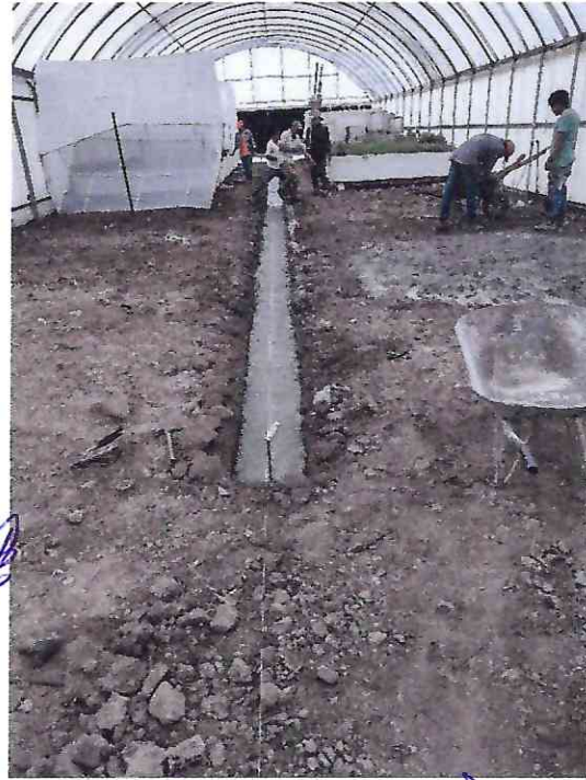
DE IGUALMANERA, SE REALIZO EL TENDIDO DE CONCRETO EN LA PLANTILLA DEL CANAL DE DESAGUE
