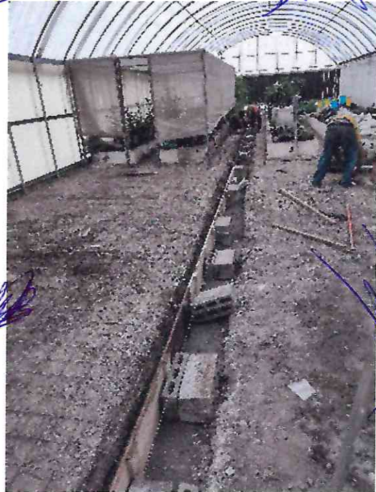
ENCOFRADO CON MADERA DE UN AREA PARA INICIAR LA COLOCACION DE PISO
