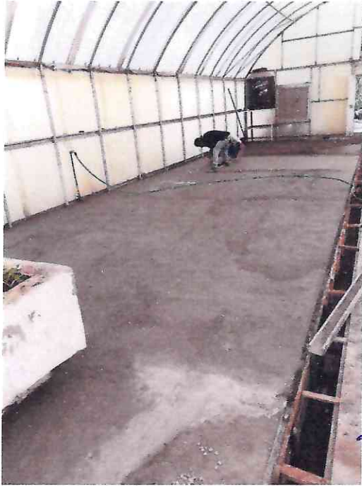
CIERRE DE LA SEGUNDA ETAPA DEL SEGUNDO TUNEL
