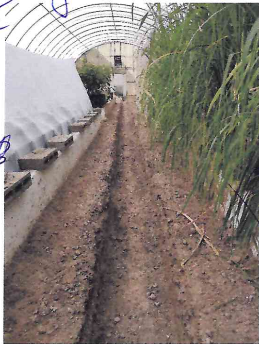
ZANJA TERMINADA, CON AFINE DE TALUD
