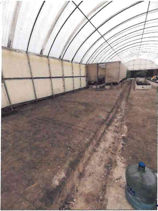
TENDIDO DE MALLA ELECTROSOLDADA, EN EL PRIMER PASILLO
