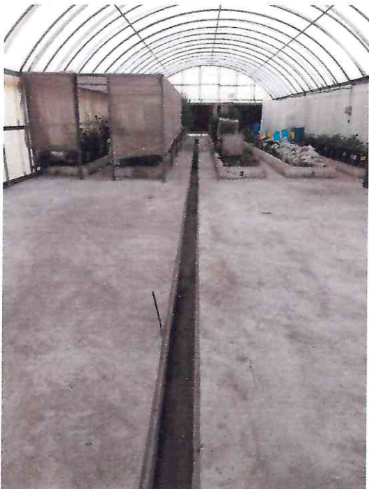
VISTA GENERAL DEL PRIMER TUNEL CON PISO DE CONCRETO
