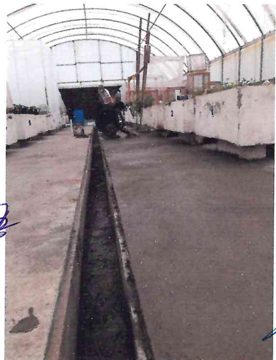
VISTA GENERAL DEL SEGUNDO TUNEL CON PISO DE CONCRETO
