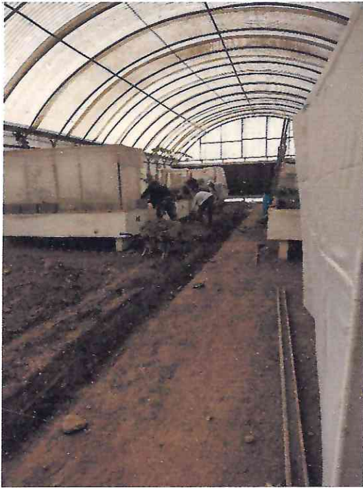
UNA VEZ TENIENDO PREPARADO TODA EL AREA DEL SEGUNDO TUNEL, SE PROCEDIO AL ZANJEO, RELLENADO Y PIZONADO
