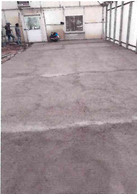
CONCLUSION DE LA PRIMERA ETAPA DEL SEGUNDO TUNEL
