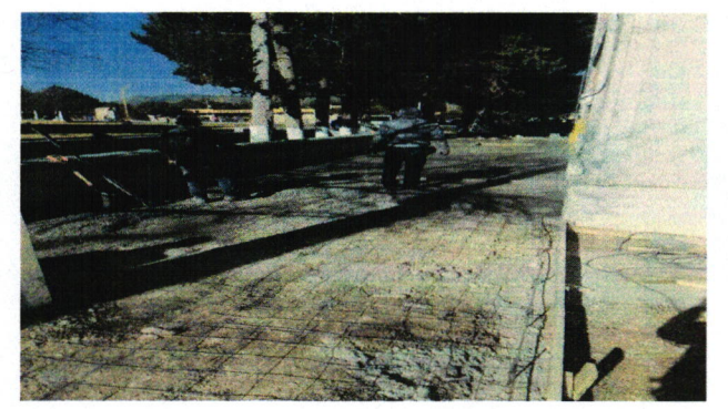
4 CONCRETO ACABADO FLOTEADO DE 10 CMS DE ESPESOR F'C= 15 KG/CM2 CON MALLA ELECTROSOLDADA 66/10-10 Y DIVISIONES DE 10 CMS A/ 3.00 MTS
