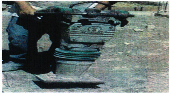
3 RELLENO CON MATERIAL INERTE PRODUCTO DE BANCO, COMPACTADO CON PLACA VIBRATORIA (BAILARINA), AGUA, EN CAPAS DE 15 CM.
