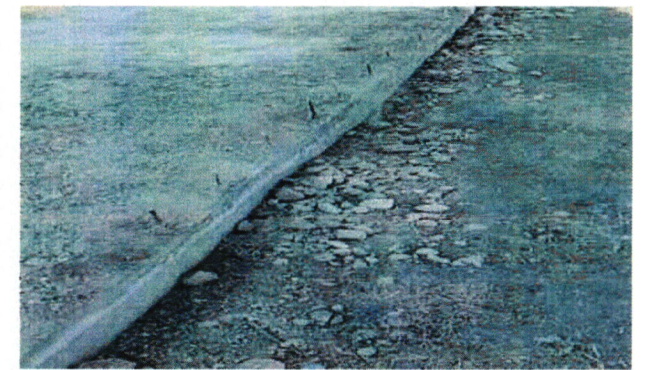
3 RELLENO CON MATERIAL INERTE PRODUCTO DE BANCO, COMPACTADO CON PLACA VIBRATORIA (BAILARINA), AGUA, EN CAPAS DE 15 CM.
