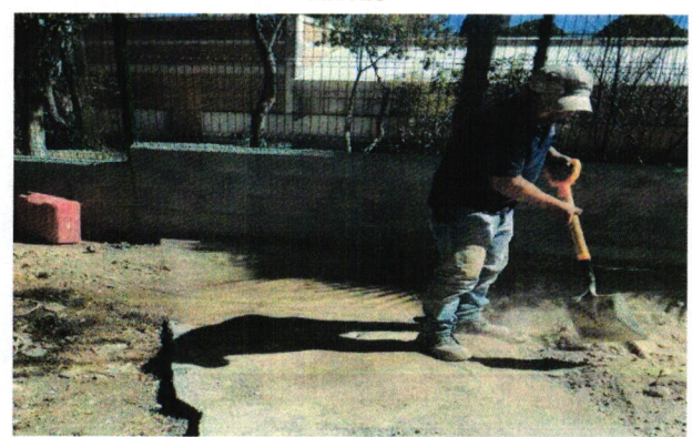
2 DEMOLICION DE CONCRETO EN BANQUETAS DE 10 CM DE ESPESOR POR MEDIOS MECANICOS Y MANUALES,
