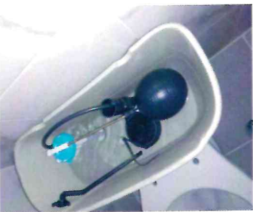
SUM. Y COLOCACIÓN DE VALVULAS
