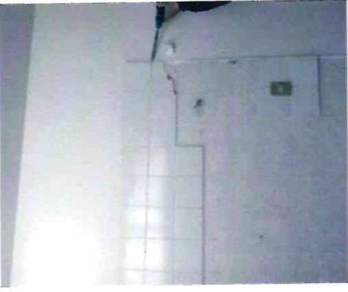
DEMOLICION DE VITROMURO
