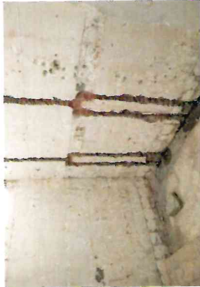
COLOCACIÓN DE VITROMURO
