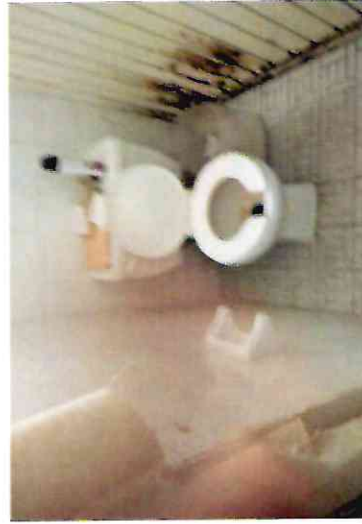
RETIRO DE LINEAS HIDRAULICAS
