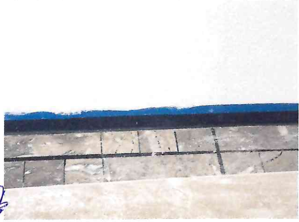
RECORTE INFERIOR DE PINTURA EN MUROS
