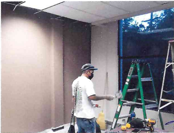
APLICACIÓN DE PINTURA DE CONTRASTE
