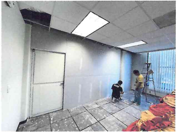
APLICACIÓN DE PASTA EN PANELES TABLAROCA
