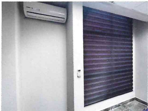
INSTALACION DE PERSIANAS EN VENTANAS
