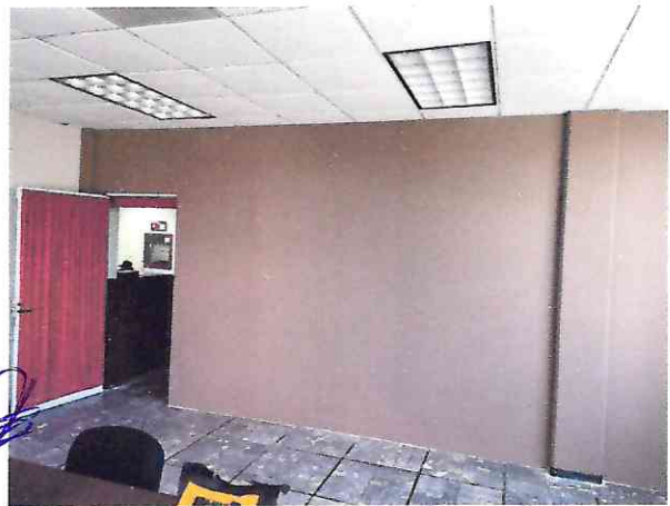
APLICACIÓN DE PINTURA DE CONTRASTE
