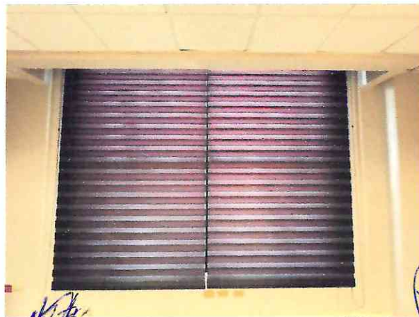
INSTALACION DE PERSIANAS EN VENTANAS
