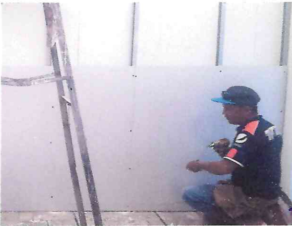
COLOCACION DE PANELES DE TABLAROCA
