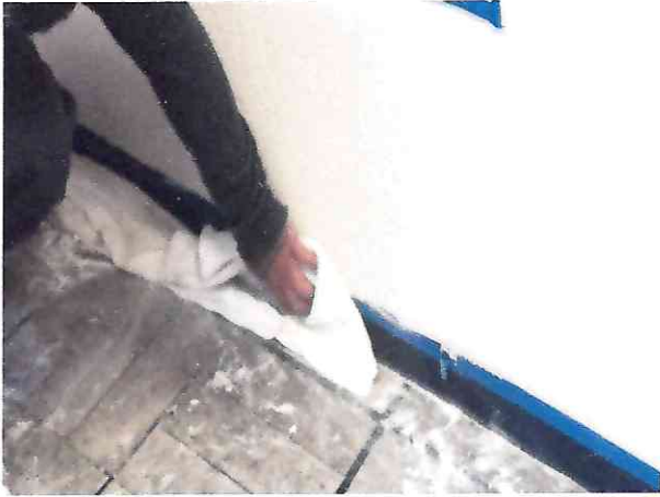
RECORTE INFERIOR DE PINTURA EN MUROS
