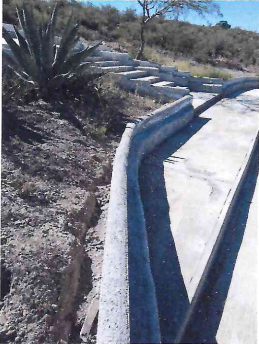
PRESENTAN MAL DISEÑO DE CURVATURA NO ASIMETRICAS
