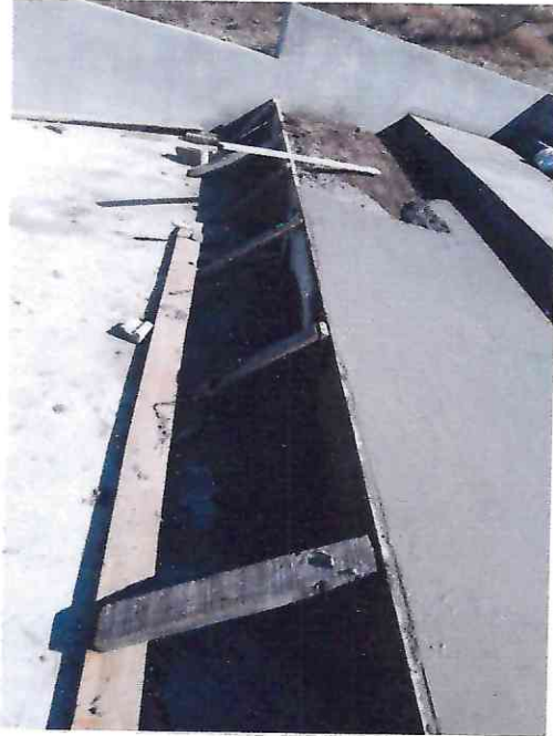
VACIADO DE HULLAS CON CONCRETO F' C: 200 KG/CM 2
