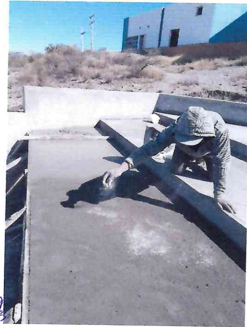
POLVEADO DE CEMENTO PARA PULIDO Y ESCOBEADO DE HUELLAS
