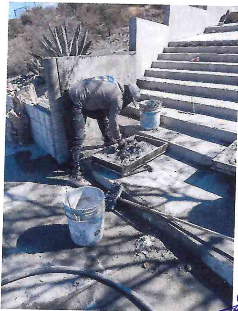
APLICACIÓN DE PASTA FINA MORTERO ARENA CEMENTO, CON HERRAMIENTA MANUAL
