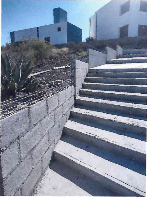
TERMINADO APARENTE DE MUROS Y PREPRACION DE CADENA DE CERRAMIENTO
