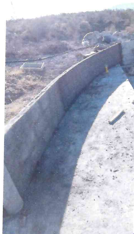
ACABADO SARPEADO, LISTO PARA SER PULIDOS
