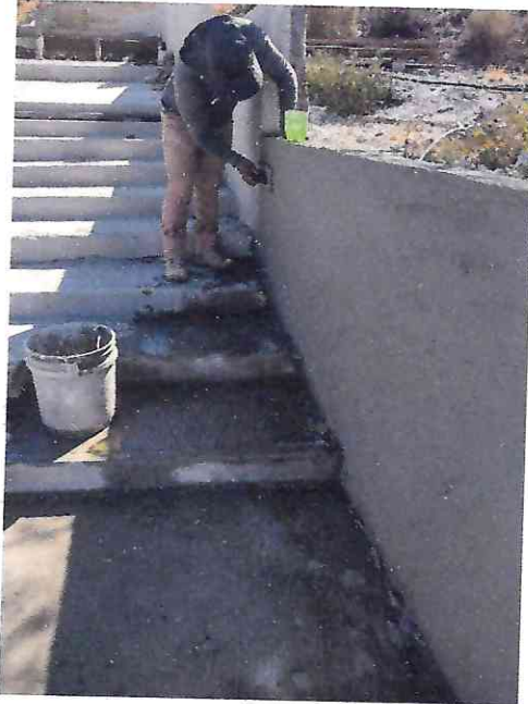
ACABADO CON HERRAMIENTA MANUAL
