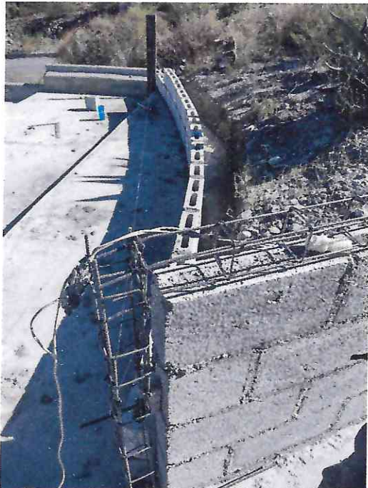
AMARRE DE MURETES CON CASTILLOS, LINEAL Y CURVADO
