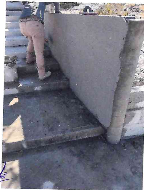
APLANADO DE PASTA FINA CON HERRAMIENTA MANUAL
