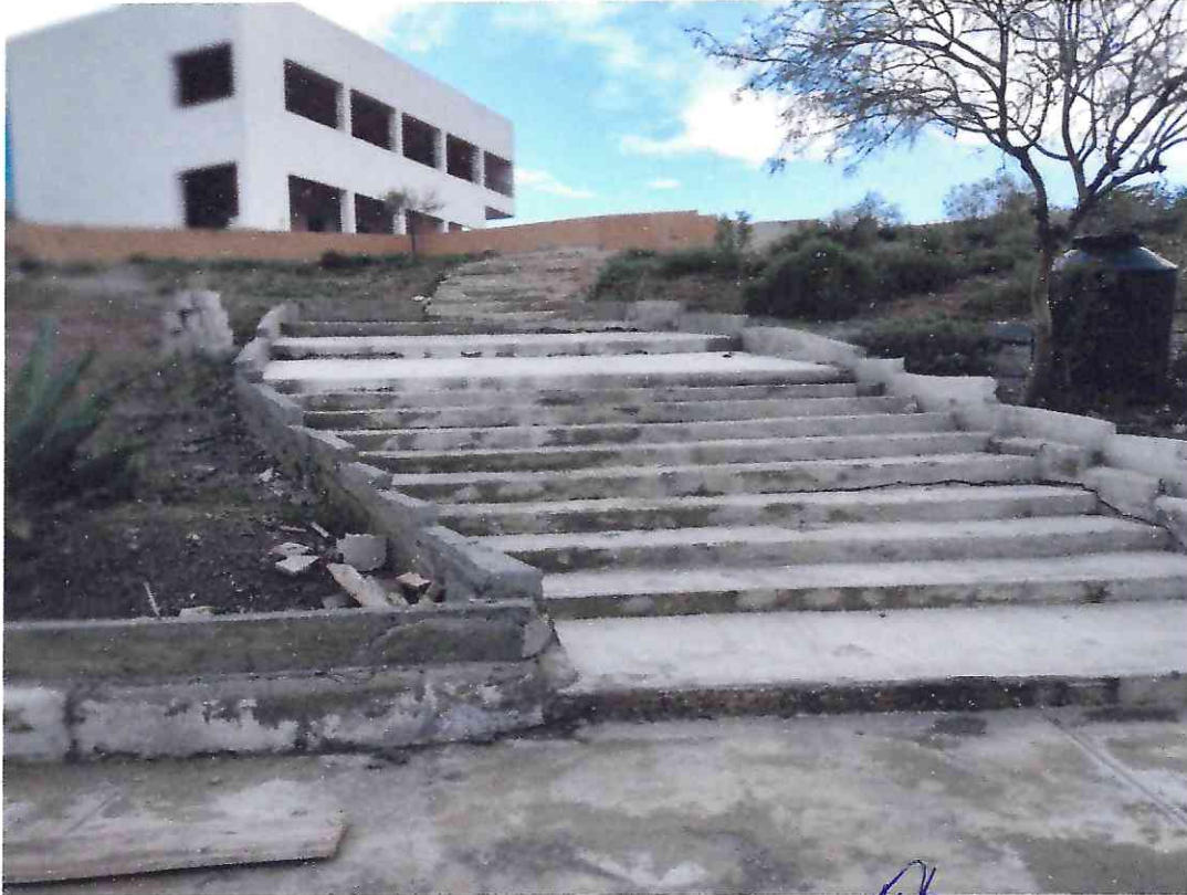
VISTA GENERAL DE GRADAS Y MURETES
