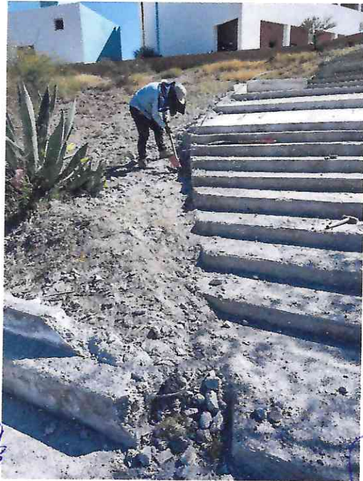
LIMPIEZA, RETIRO DE ESCOMBRO
