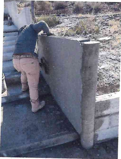
PULIDO DE PASTA FINA CON HERRAMIENTA MANUAL
