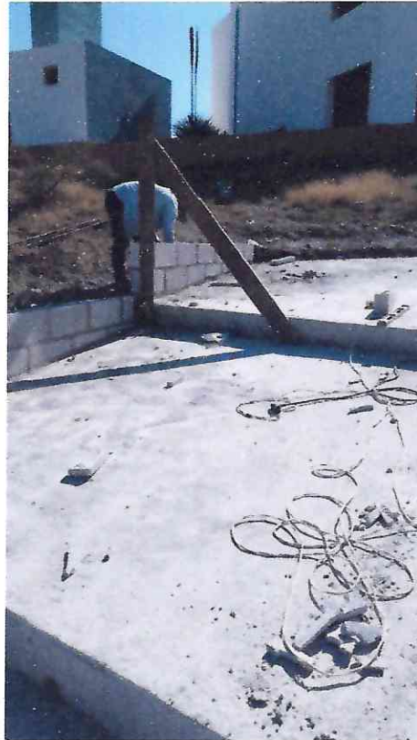
ASENTADO DE BLOCK'S CON MORTERO ARENA-CEMENTO PRO. 1:4
