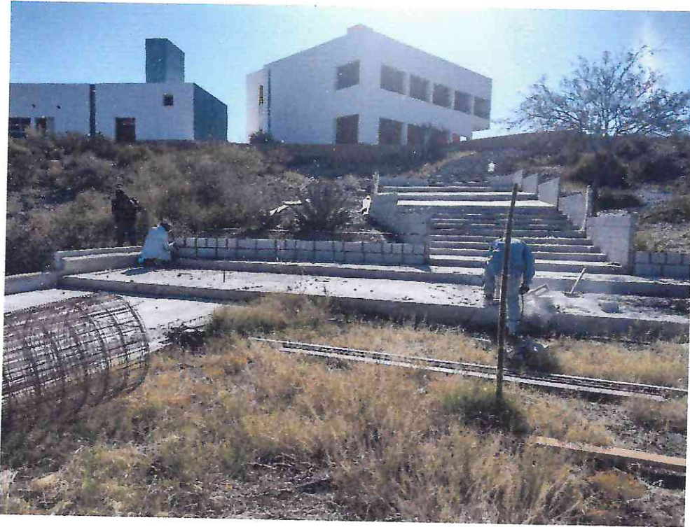
VISTA GENERAL DE AVANCE DE AMBOS LADOS DE GRADAS, CON ACABADO APARENTE
