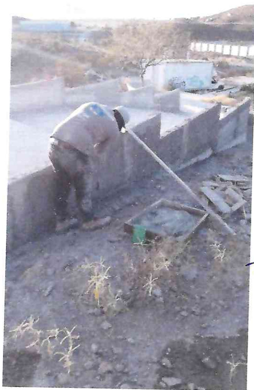
SARPEADO DE MURETES, APLANADO
