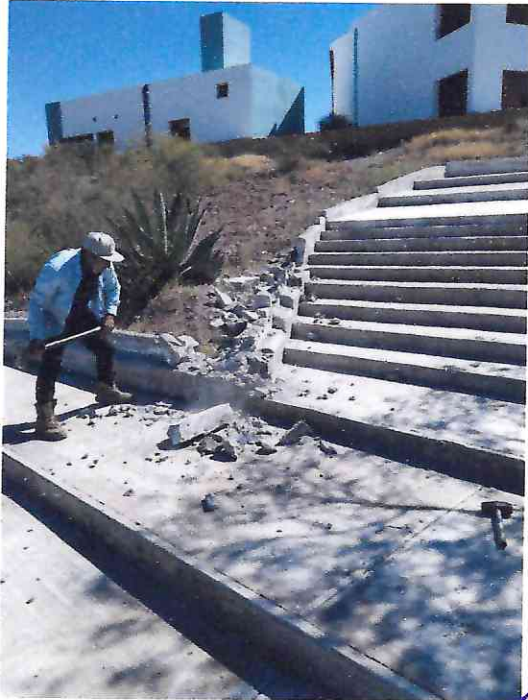
DEMOLICION DE MURETES, LADO IZQUIERDO
