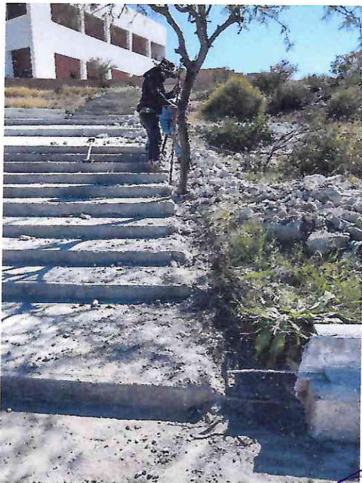
DEMOLICION DE MURETE, LADO IZQUIERDO
