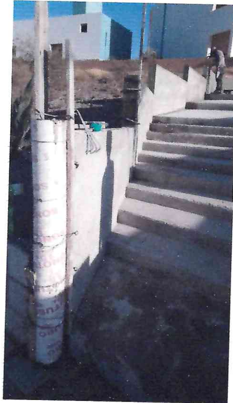
TERMINO DE MURETE CON CATILLO Y FRAGUADO CON SONOTUBO DE 6"
