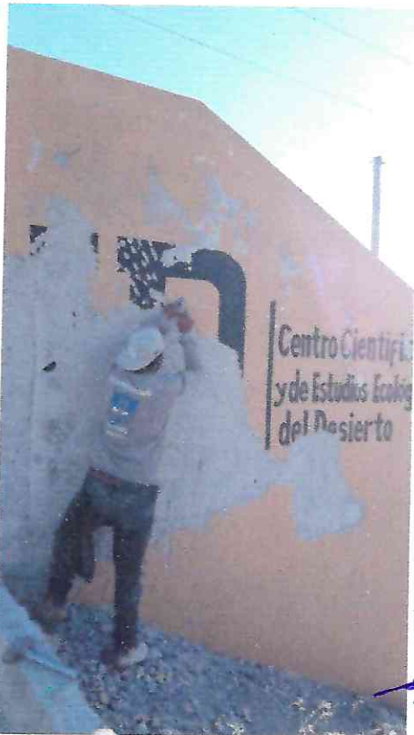
PREPARACION DE MUROS DE ENTRADA, CON HERRAMEINTAS MANUALES
