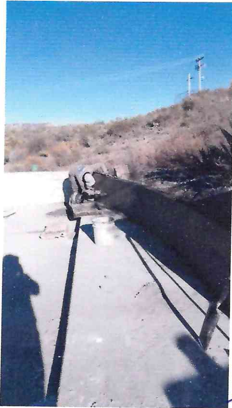
SARPEADO DE MUROS LATERALES
