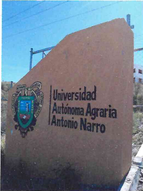
MURO ENTRADA PRINCIPAL LADO IZQUIERDO, PRESENTA PROBLEMAS DE DESMORONAMIENTO
