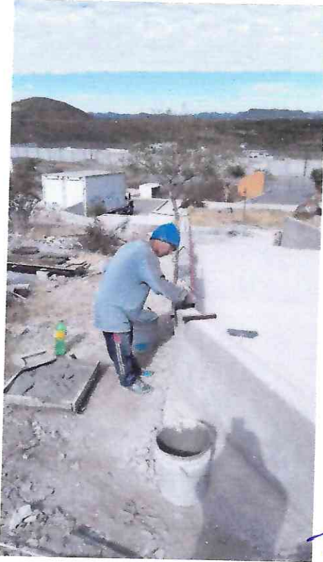
ACABADO DE MURETES, APLICACIÓN DE PULIDO-FINA, MANUAL
