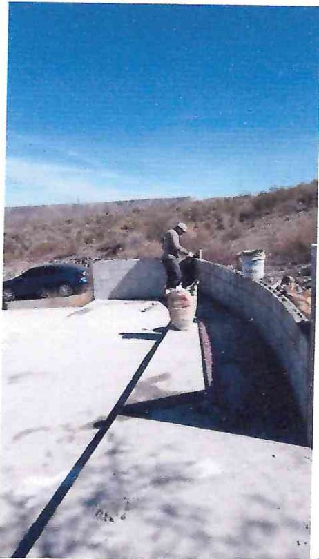
VACIADO DE CASTILOS EN LATERALES DE MEDIA LUNA DE MURO
